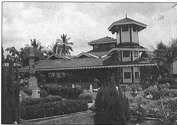
Masjid Komplek Pasir Salak.
